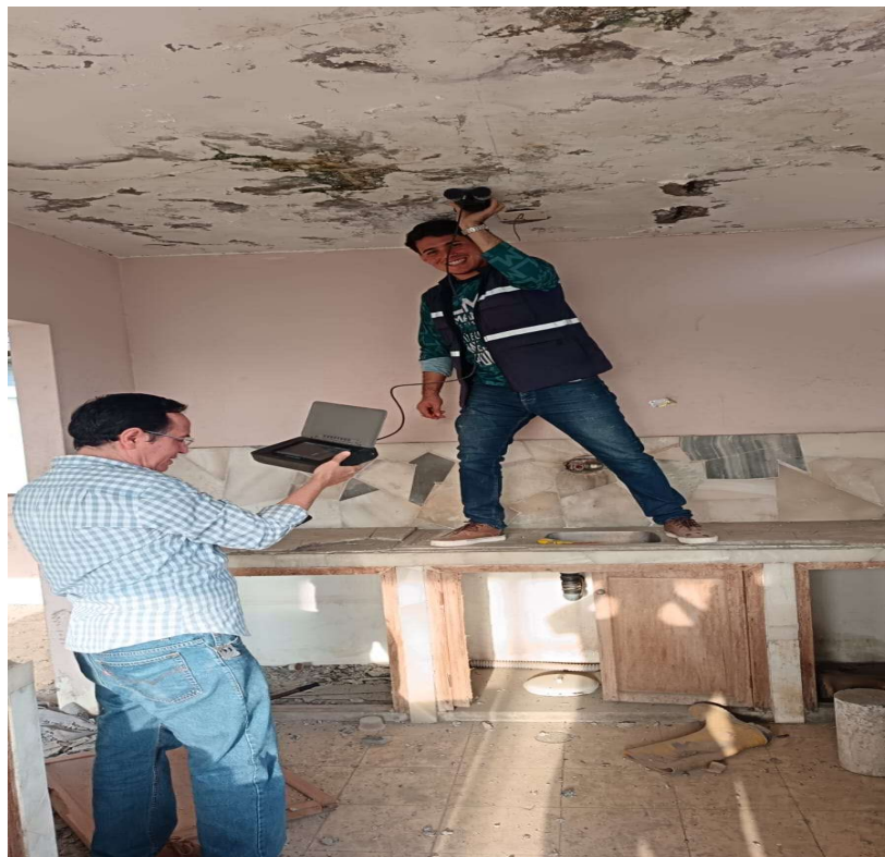
Anexo 7. Pachometría a la losa para ver el armado.
