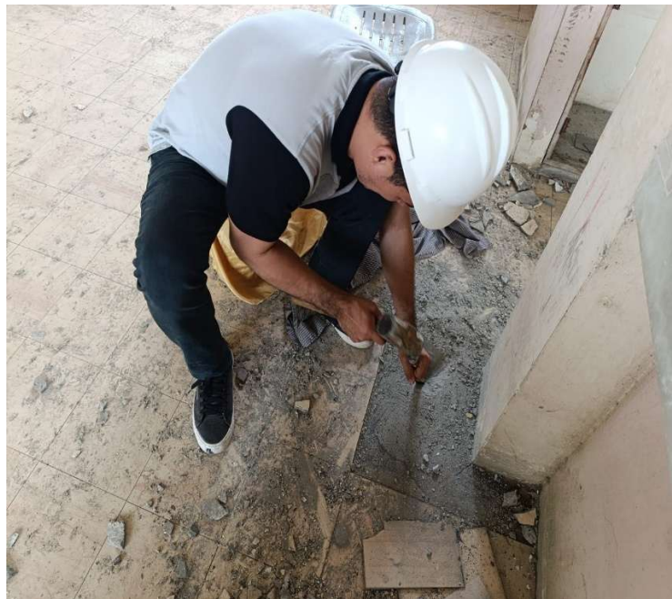
Anexo 5. Inspección destructiva en la losa para conocer estribos de vigas.
