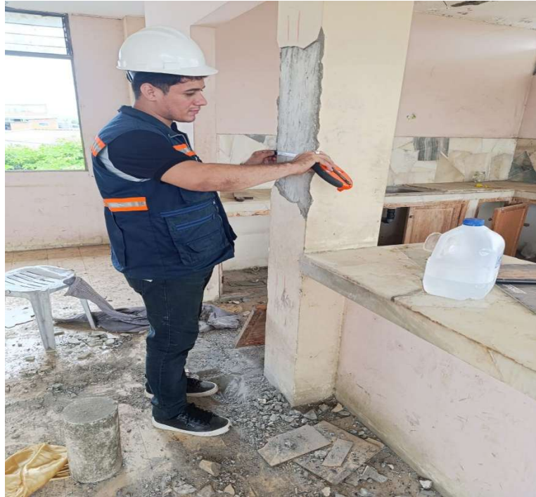
Anexo 4. Medición con cinta de elementos estructurales.
