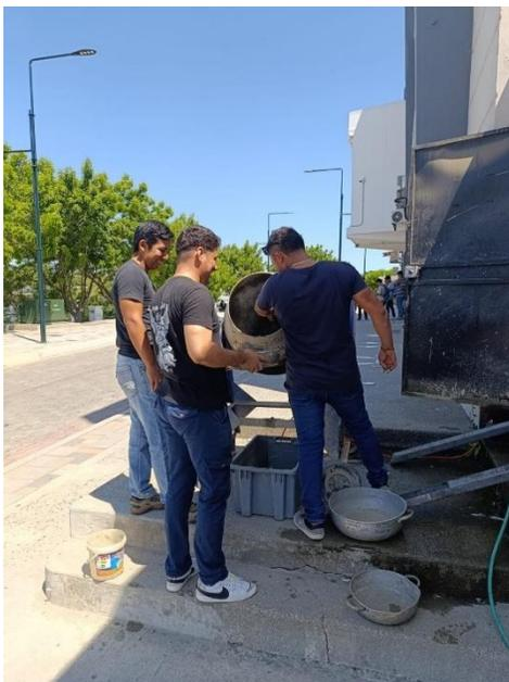
**Figura 15.** Comprobación de la consistencia del hormigón
