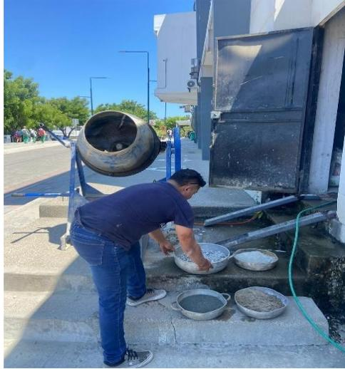
**Figura 13.** Mezclado de materiales en concretera.
