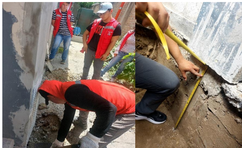
Figura 3.8. Excavación para la caracterización de la cimentación. (Autor)
