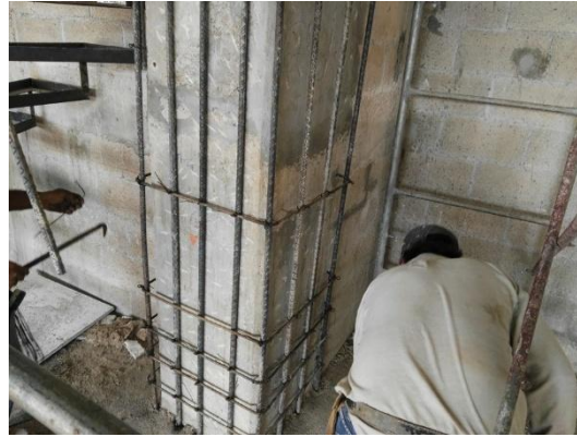
Figura 2.6. Armado para revestimiento de columna. (Habitissimo)
