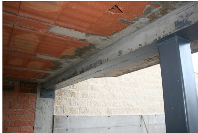
Figura 2.8. Refuerzo estructural de viga. (Peritar Arquitectura)
