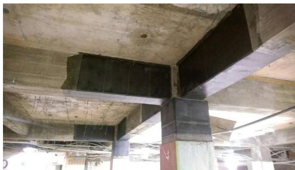
Figura 2.7. Revestimiento con malla de carbono FRP. (J. Julián y asociados)
