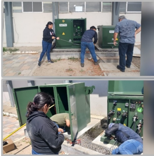
Figura 48 Proceso de tendido del cable de forma soterrada para la alimentación del medidor
