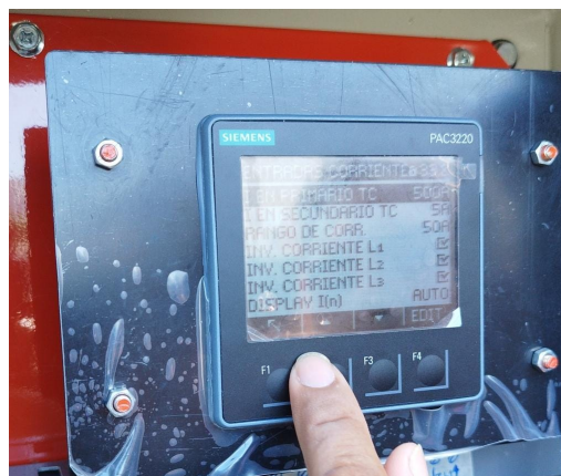
Figura 54 Configuraciones básicas de la pantalla y configuración de los TC del medidor SENTRON PAC 3220
