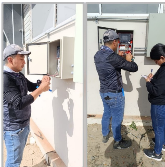
Figura 49 Colocación de los elementos dentro de la caja y colocación de punteras en los cables
