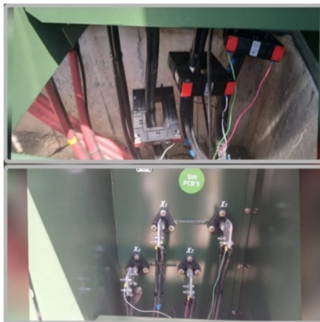
Figura 51 Cableado y colocación de terminales tipo ojo y tipo u en los pasatapas y en los TCS
