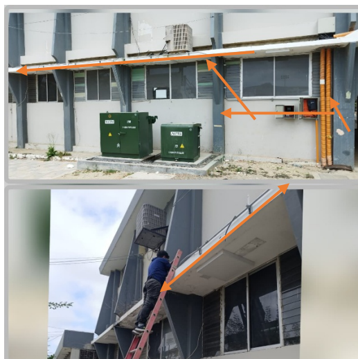
Figura 56 recorrido externo del cable de comunicación desde el medidor hasta el rack principal de derecho
