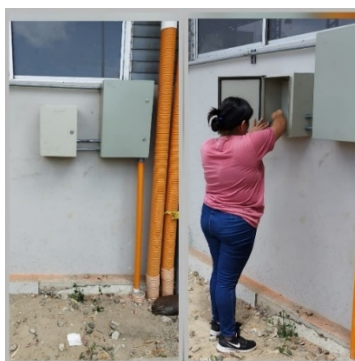
Figura 44 Fijación de la caja donde será colocado el medidor SENTRON PAC 3220 de la Facultad de Derecho
