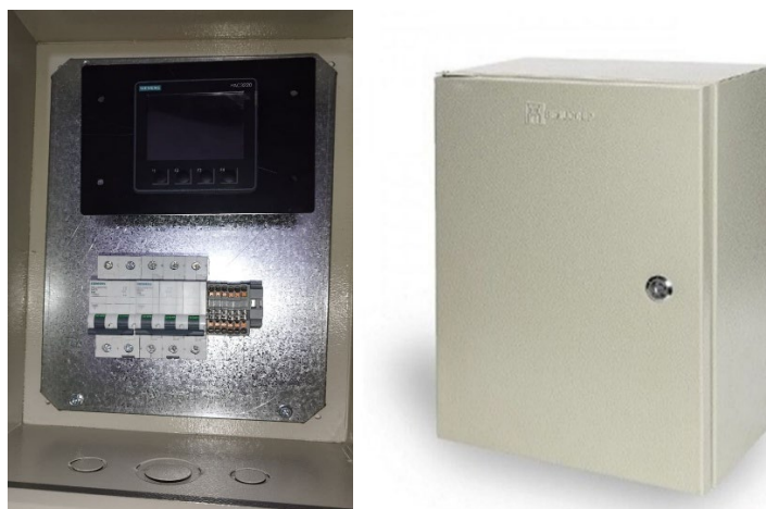
Figura 38 Tablero utilizado para la realización de instalación eléctrica del medidor SENTRON PAC 3220, los elementos a utilizar
