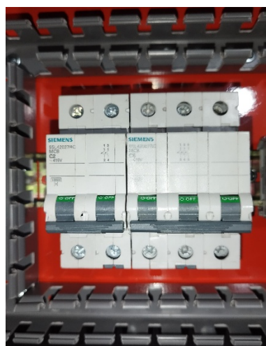
Figura 39 Colocación y fijación de los breakers de alimentación y medición dentro del tablero
