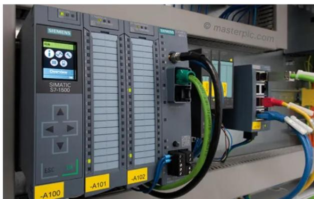
Nota. Imagen real de un PLC en procesos industriales. Extraído de <https://masterplc.com/automatizacion/controlador-logico-programable/>
