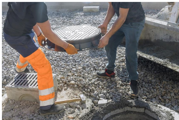
Figura 12. Correcto manejo para la colocación de tapas de pozo
