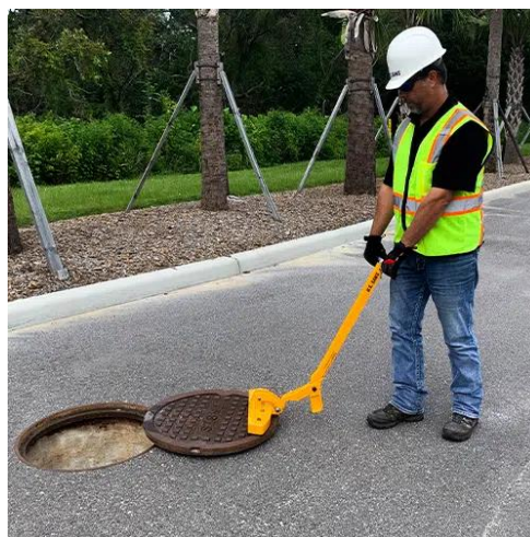
Figura 14. Correcto retiro de tapas de pozo para mantenimiento con implementos y menor esfuerzo físico
