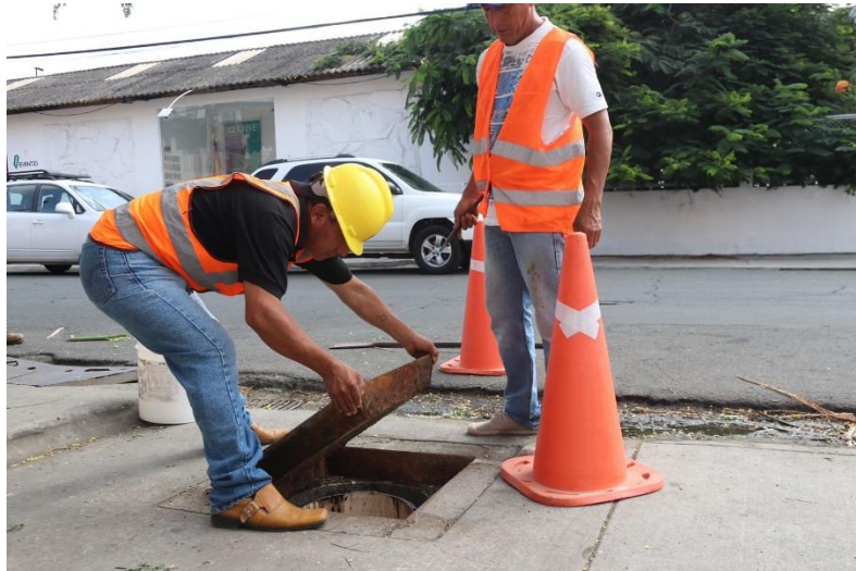
Figura 9. Retiro de tapas de pozo para mantenimiento -Evaluación ergonómica
