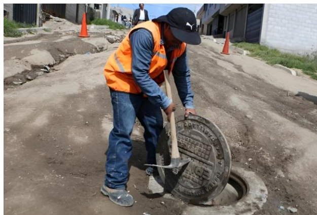
Figura 5. Colocación de tapas de pozo -Evaluación ergonómica
