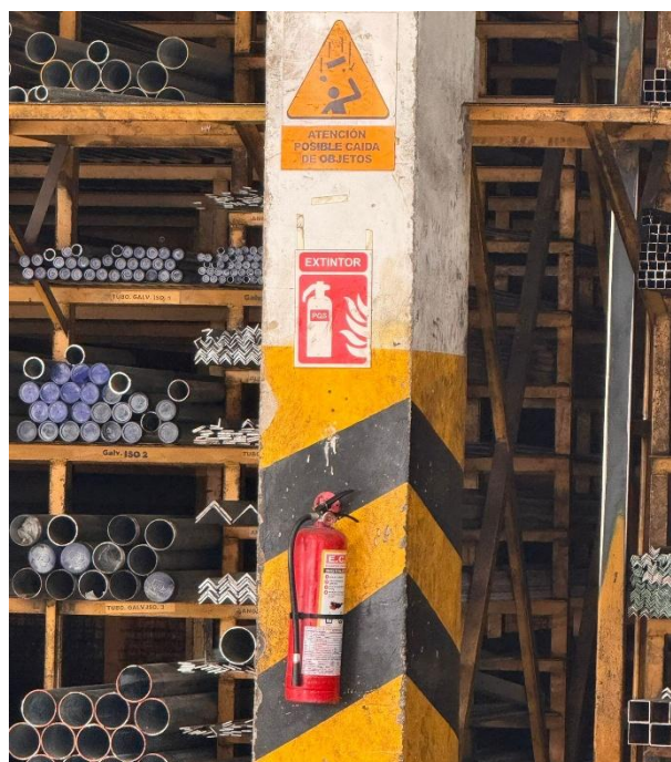
Figura 22. Señales ubicadas en el área de almacenamiento de materiales: advertencia por posible caída de objetos y ubicación de extintor tipo PQS, colocadas sobre columna señalizada para alta visibilidad.
