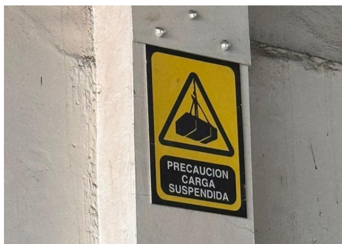
Figura 20. Señal de advertencia “Precaución: carga suspendida” ubicada en el área de izaje, utilizada para alertar sobre el riesgo de caída de objetos durante maniobras con grúas o equipos de elevación.
