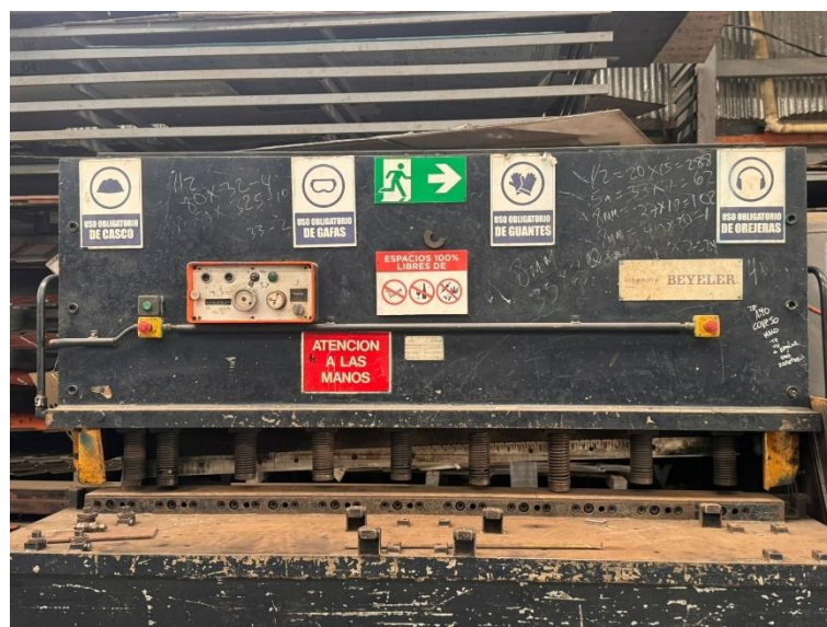
Figura 24. Señalización ubicada en máquina de corte: uso obligatorio de casco, gafas, guantes y orejeras, junto con advertencias de evacuación, prohibiciones y precaución en las manos. Elementos clave para la operación segura del equipo.
