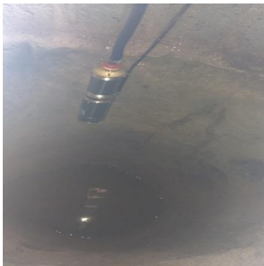
Figura 7 Instalación de la bomba
