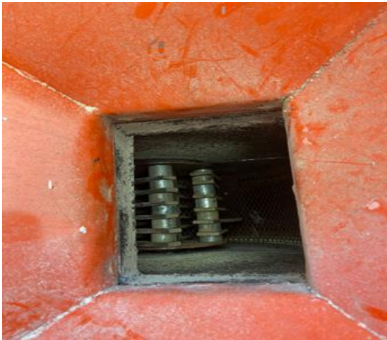
Anexo 3. Parte interna
