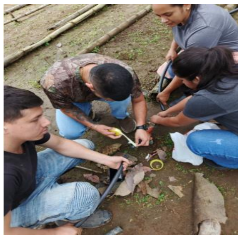
Anexo 4. Instalación de T con su respectiva llave de paso
