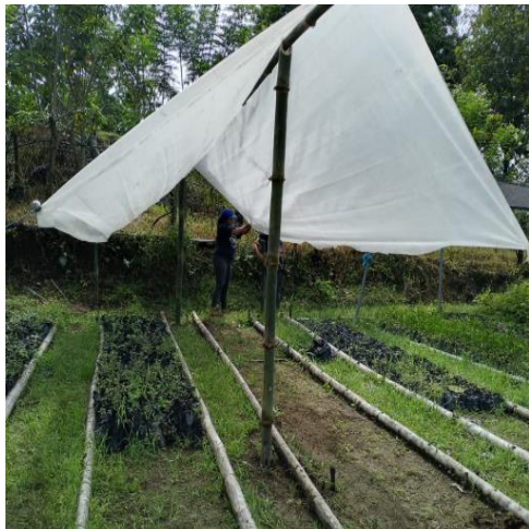
Anexo 3. Construcción del umbráculo.
