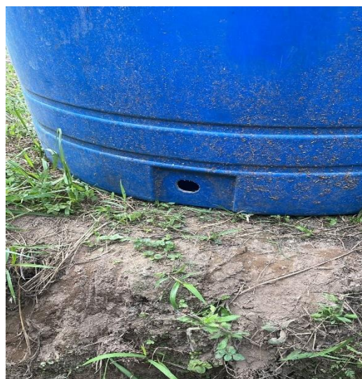
Anexo 13 adecuación del tanque de agua
