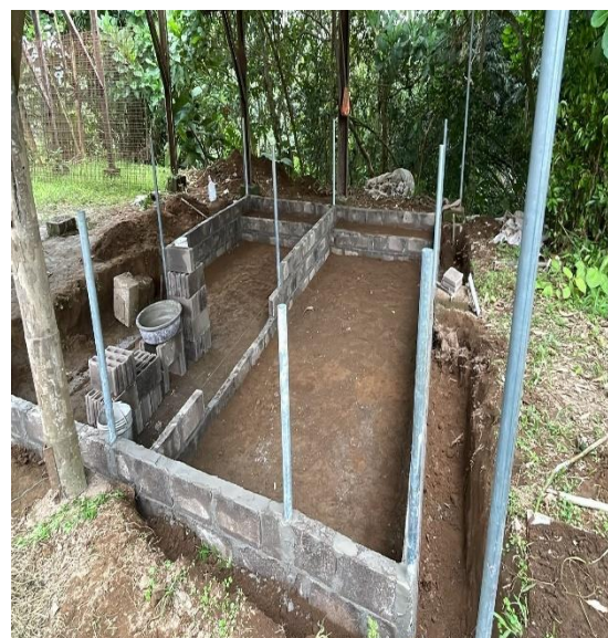
Anexo 9 columnas de acero y paredes de bloques
