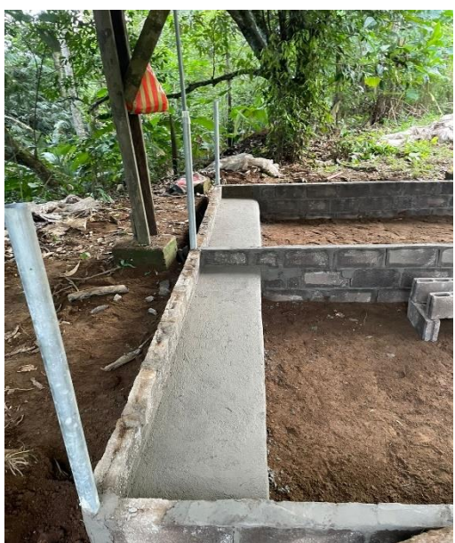
Anexo 10 Relleno piso para bebederos
