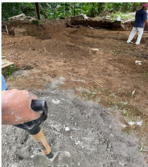
Anexo 8 construcción de muros
