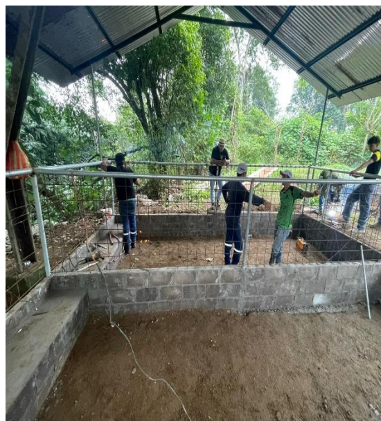
Anexo 11 Soldadura de las mallas sobre los bloques
