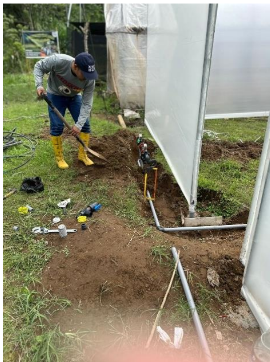
Ilustración 19. Instalación del sistema de riego por microaspersión
