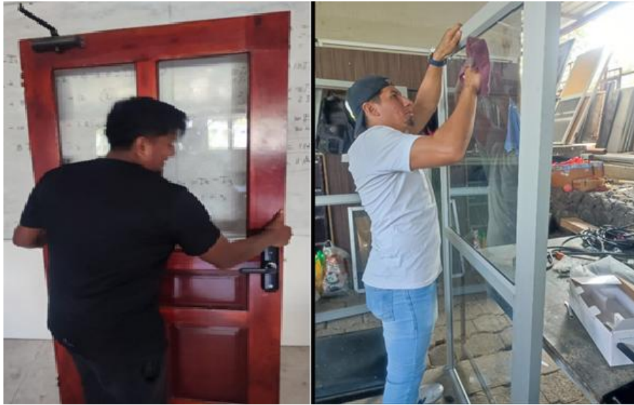
Ilustración 6. Proceso de diseño y adecuación de las instalaciones intervenidas.
