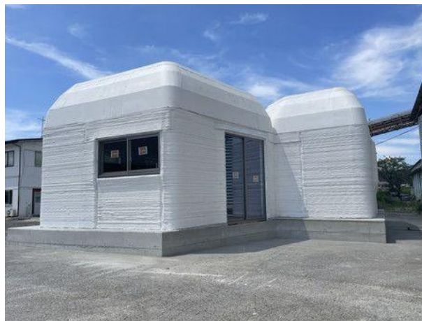
Figura 7. Casa sismorresistente impresa 3D en Japón. Fuente: Nippon.com (2023)
