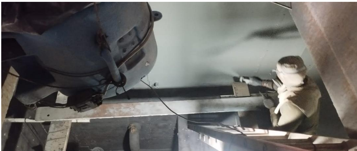
Figura 16. Aplicación de primera capa de fondo a cuba
