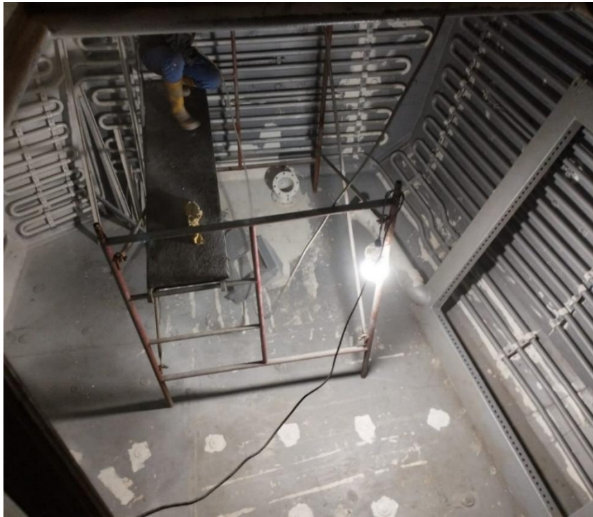
Figura 22. Pintura a serpentines manualmente
