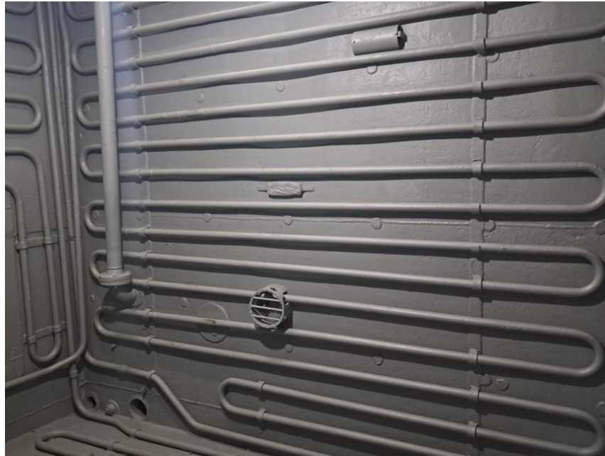
Figura 20. Serpentines instalados
