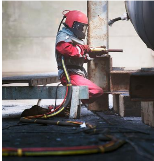
Figura 11. Aplicación de granallado (sandblasting)
