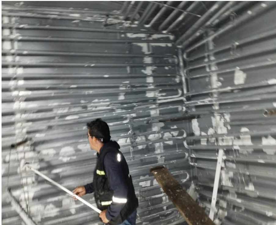
Anexo. 6. Operarios realizando labores de acabados de fondo dentro de la cuba.
