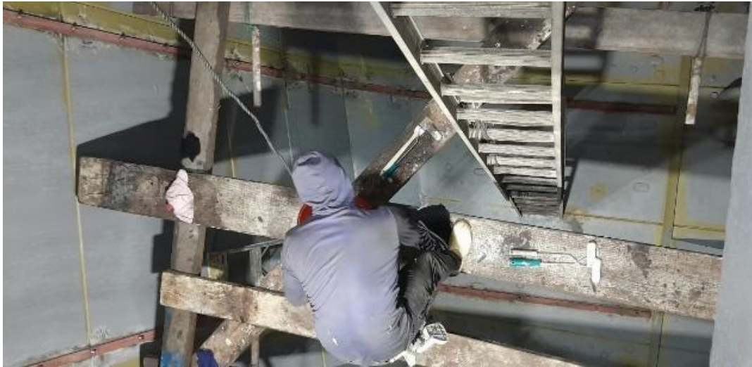
Anexo. 5. Operarios realizando labores de acabados de fondo, utilizando tablones
