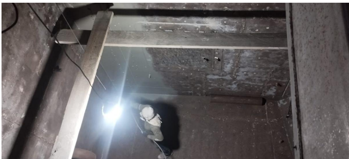
Figura 13. Cuba después del granallado (sandblasting)
