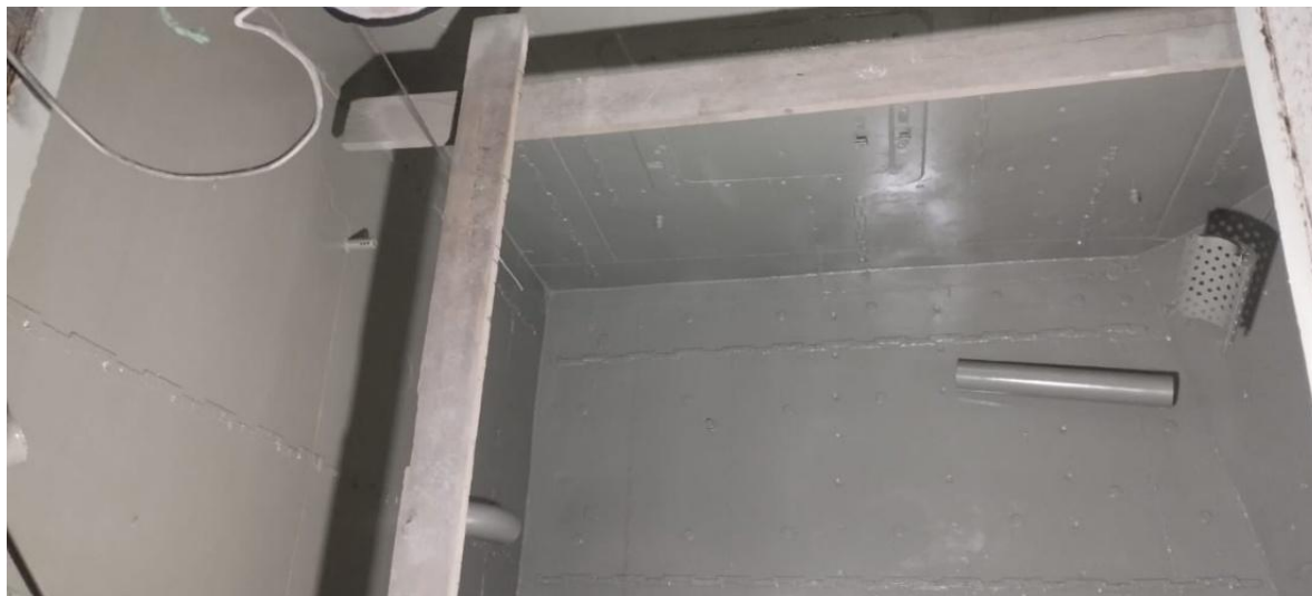
Figura 17. Cuba con primera capa de fondo aplicada
