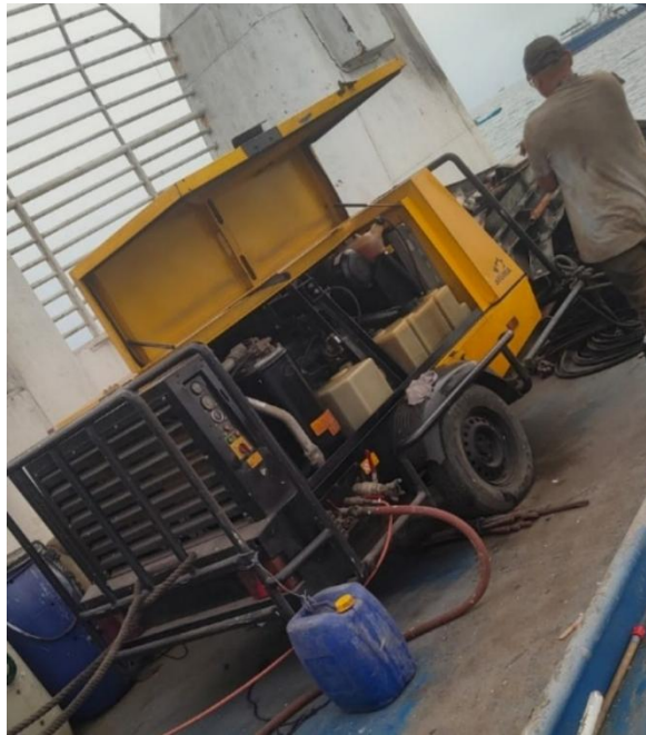
Figura 9. Máquina de granallado (sandblasting)
