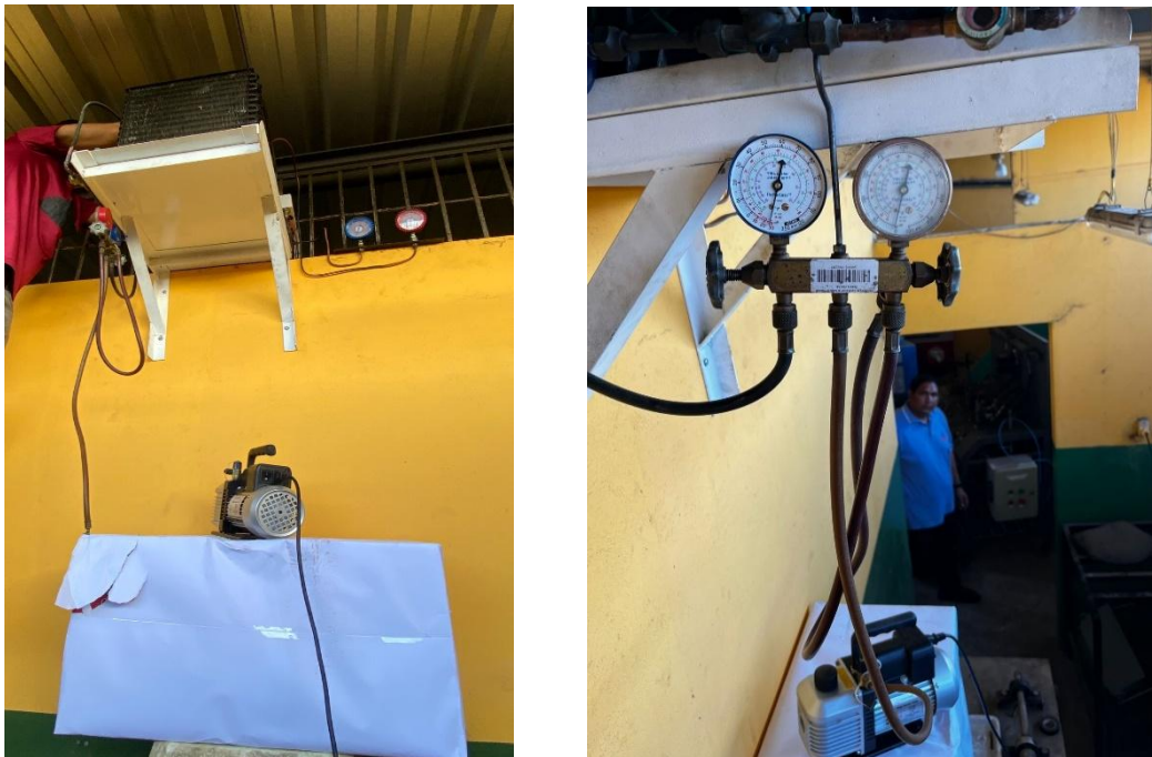
Ilustración 27 Vacío del sistema.
