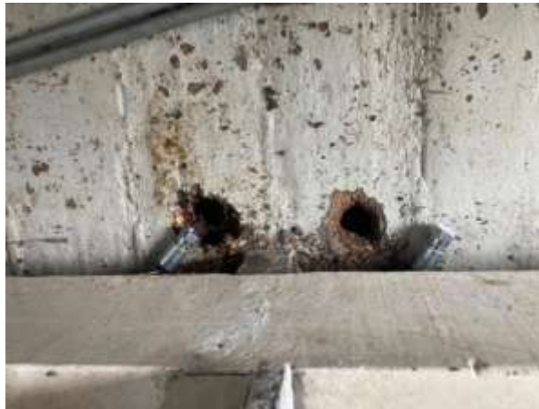
Ilustración 40 Huecos salientes de sala de máquinas
