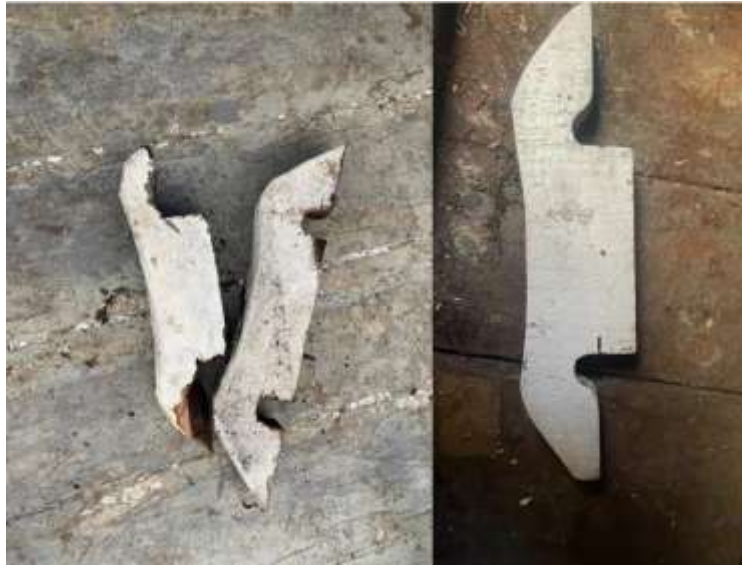
Ilustración 31 Antes y después de soporte de tuberías
