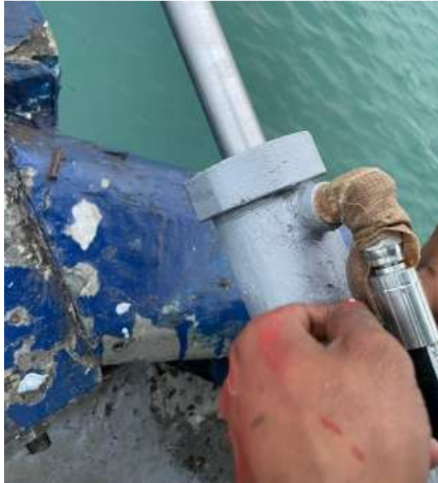
Ilustración 21 Recubrimiento con cinta engrasada
