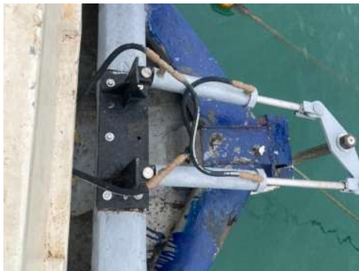
Ilustración 22 Todos los accesorios recubiertos con cinta engrasada expuestos al mar
