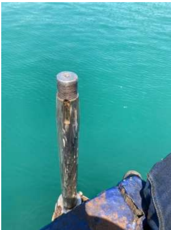
Ilustración 17 Soporte macho restaurado
