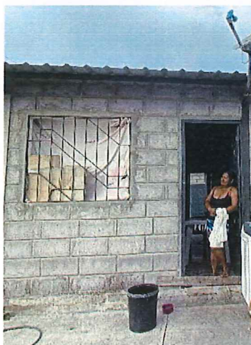
Ilustración 5. Identificación de Tipologías de vivienda por material. V2: Bloque de hormigón (CHORRERA MEDIA)
