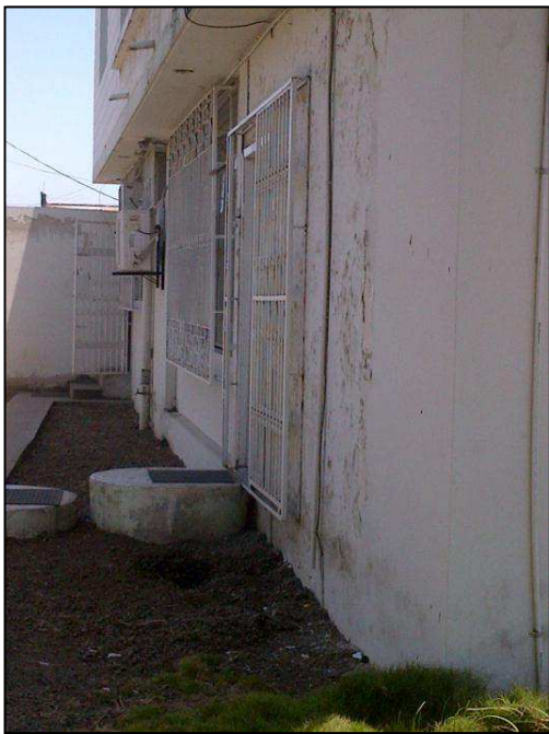
Fachada exterior de la Fundación
